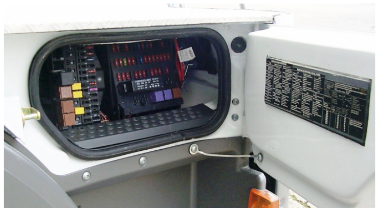
Abbildung 3- Einfacher Zugriff auf Bordelektrik an Beifahrerseite
